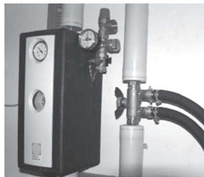
3. Anslut tryckslangen (1) och returslangen (2) påfyllningsventilen och öppna kulventiler. Stäng kulventilen (3).
