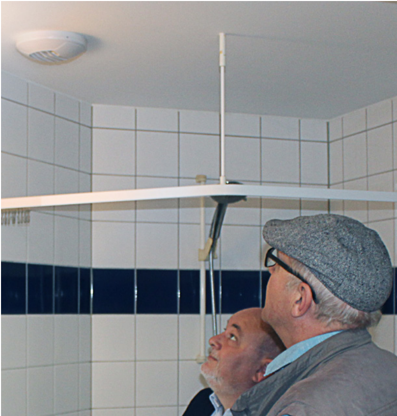
Neotherm ventilen på badeværelset åbner og lukker for ventilationen efter behov.
