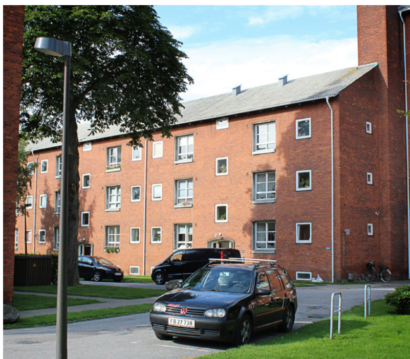
291 lejligheder i Valbyholm får bedre indeklima med behovsstyret ventilation fra Neotherm.
